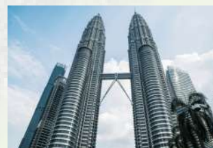
KUALA LUMPUR CONVENTION CENTRE (KLCC)
